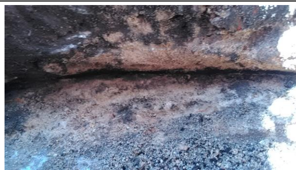
Asfaltová izolace ve spáře
