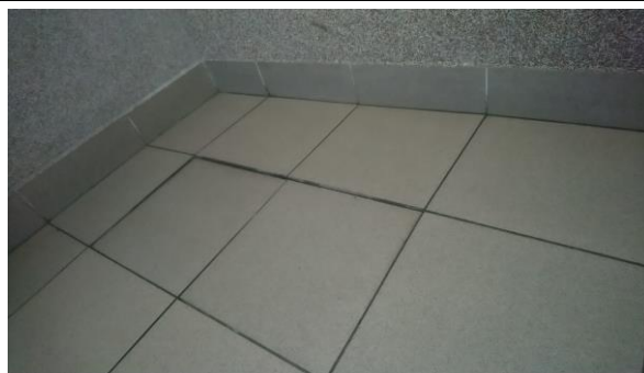
Vzdouvající se dlažba
