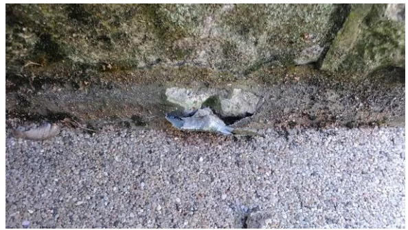
Odlepující se stěrka povrchové hydroizolace
